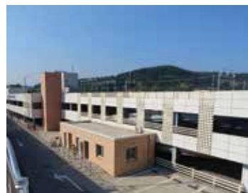
남창옹기종기시장 승강기 설치공사
